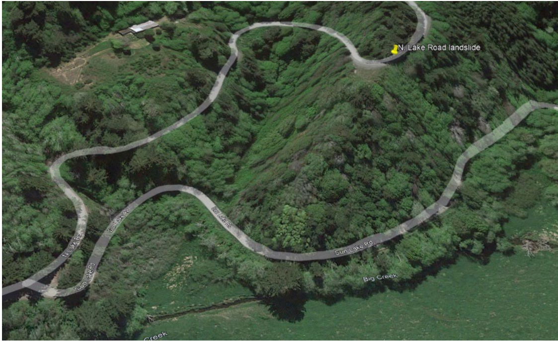
Figure I-27. N. Lake Rd Landslide Location
